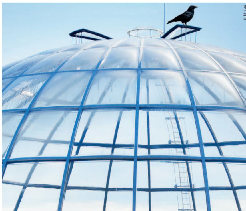
Filigrane Konstruktion: Auf das vorhandene Bauskelett wurde eine neue Hightech-Hülle montiert.
